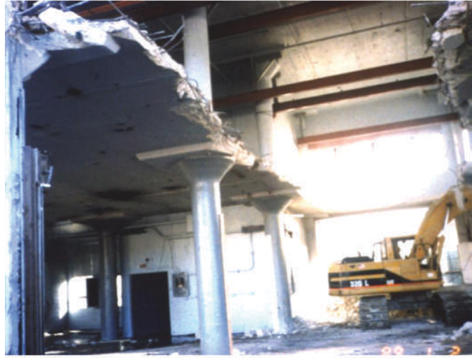
شكل رقم (7) - الهدم بواسطة الحفار
