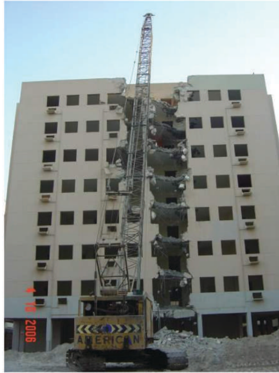
شكل رقم (10) - الهدم باستخدام الكرة
