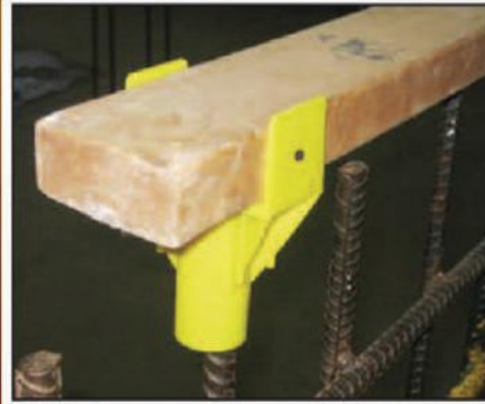
تغطية حديد التسليح بواسطة ألواح من الخشب للحماية من مخاطر اختراق الجسم شكل رقم (4)
