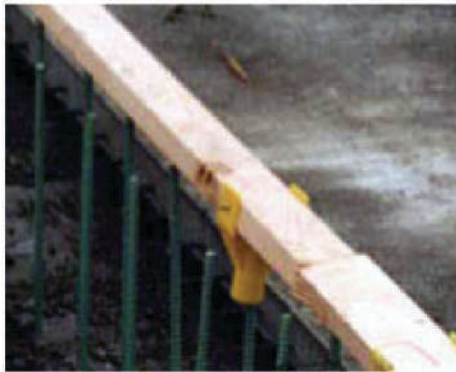
تغطية حديد التسليح بواسطة ألواح من الخشب للحماية من مخاطر اختراق الجسم شكل رقم (4)
