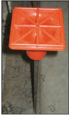
حديد التسليح وقد تمت تغطية أطرافه المدببة - Capped Rebar شكل رقم (4)
