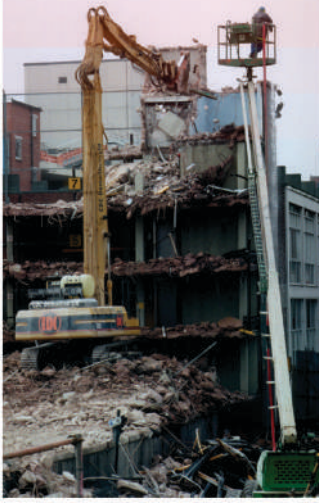
شكل رقم (8) - الهدم بواسطة داقوس الهدم
